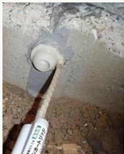
基礎ひび割れに対し、エポキシ樹脂注入によるクラック補修を行います。
