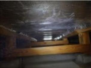
ポリスチレン系断熱材による断熱施工を行います。
